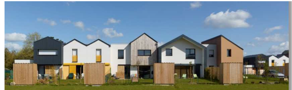
Opération groupée « Vert Buisson » à Bruz (35)
